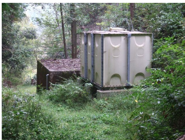
旧岩倉温泉の泉源貯水タンク
