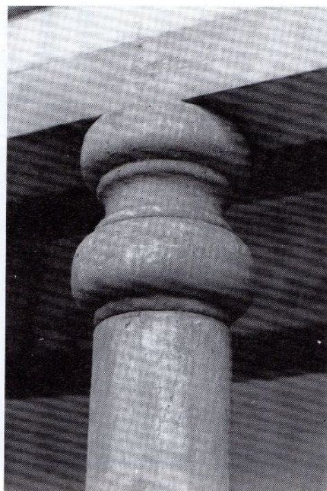
ベランダ柱列の柱頭繰型（右）及び 柱脚繰型礎石（左）
