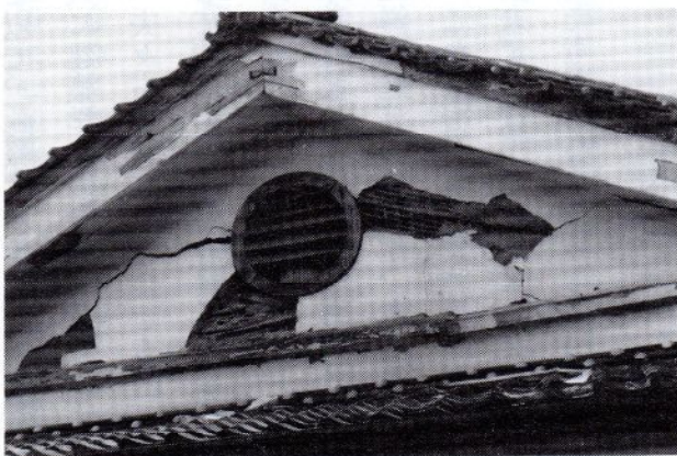
事務所棟小屋裏換気孔（上）と議事堂棟小屋裏換気孔（下）
