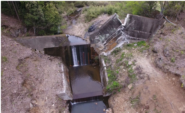
写真 1 地滑りで被災砂防ダム
