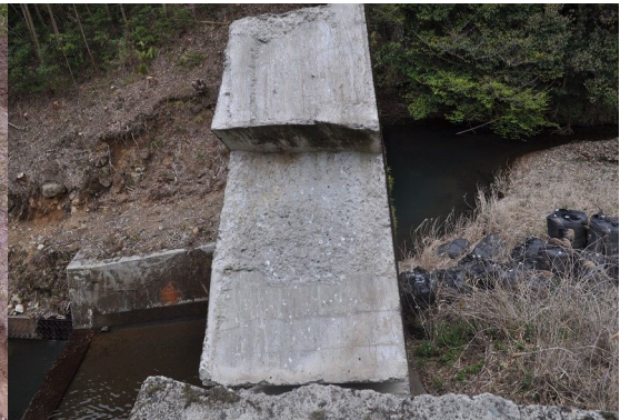
写真 2 被災した砂防ダムの破断面
