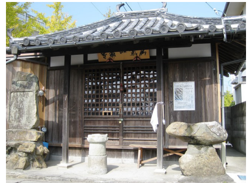
修復の終わった脚気地蔵堂
